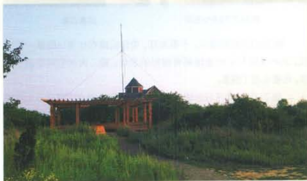
倒V方式架设起的G5RV天线
