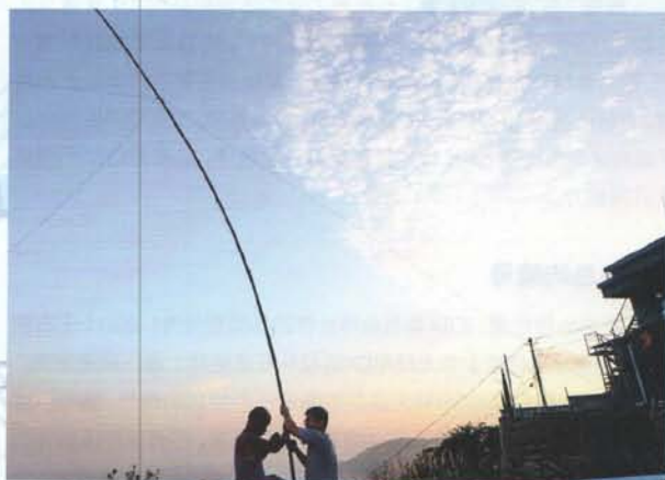
架设无竹竿支撑的GP天线
