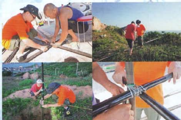
组装蛛网八木天线、40m波段GP天线
