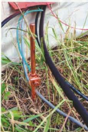
进入帐篷的馈线、旋转器控制线和接地
