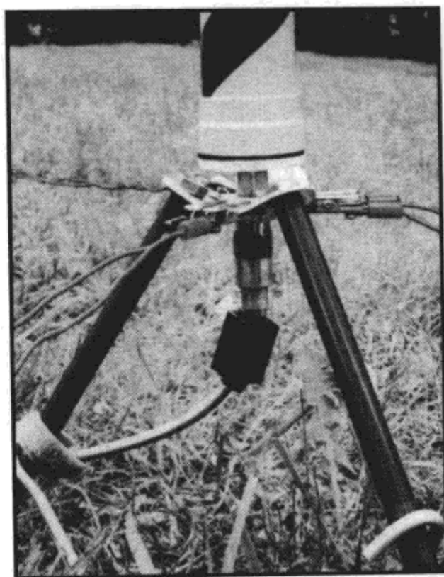
图 6-27 飞蝇杆天线底部。尼龙垫片把地线和三角架与振子隔离开。三角架上的三角形板是一只 HustlerVP-1 三波段转接器。
