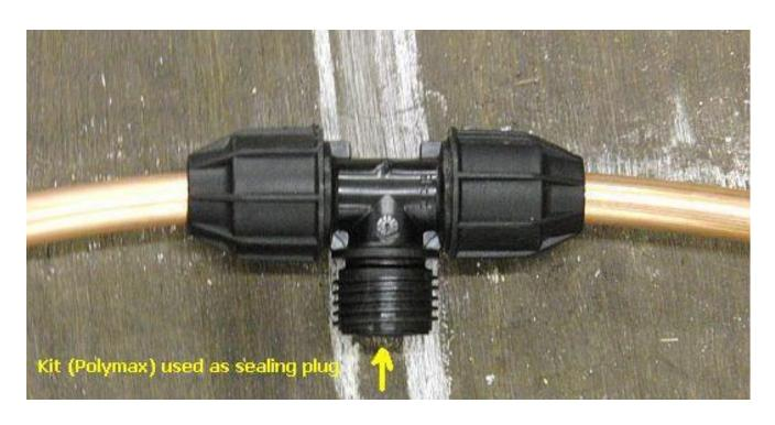
安装在立管上的塑料 T 型连接器用合适的套件(如 Polymax)密封,以避免任何漏水或冷凝。
